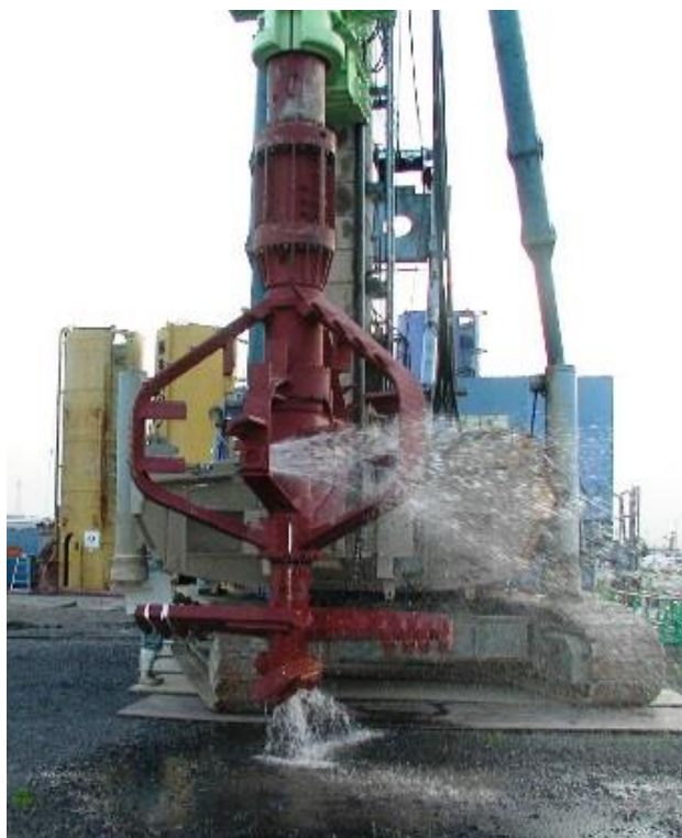
エポコラム工法攪拌翼( \phi 2.3m例)
