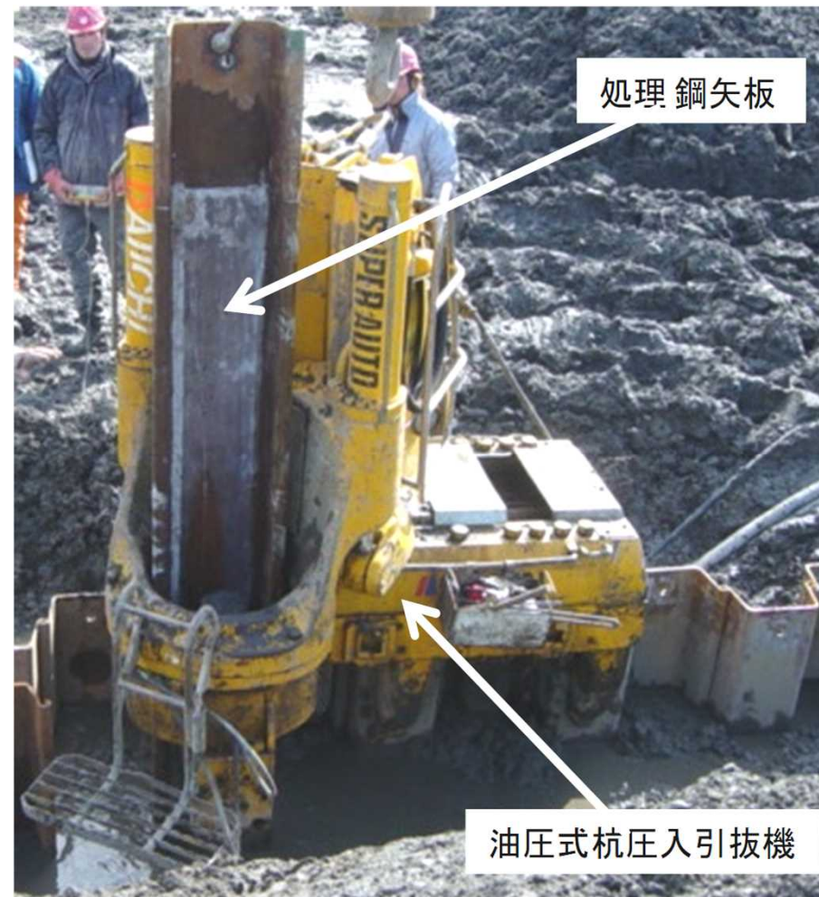
油圧パイラーで圧入打設
