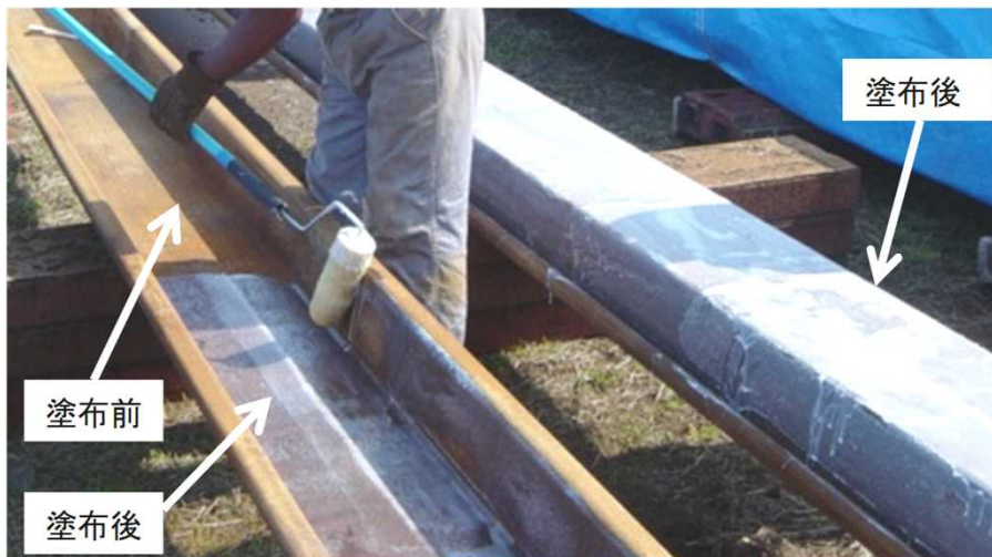
鋼矢板へのフリクションカッター塗布
