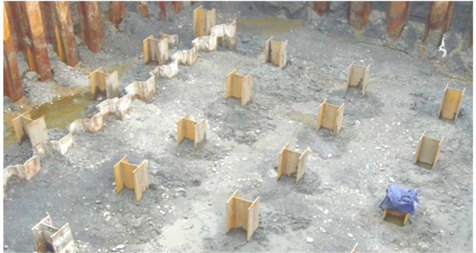
バイブロハンマーで圧入打設
