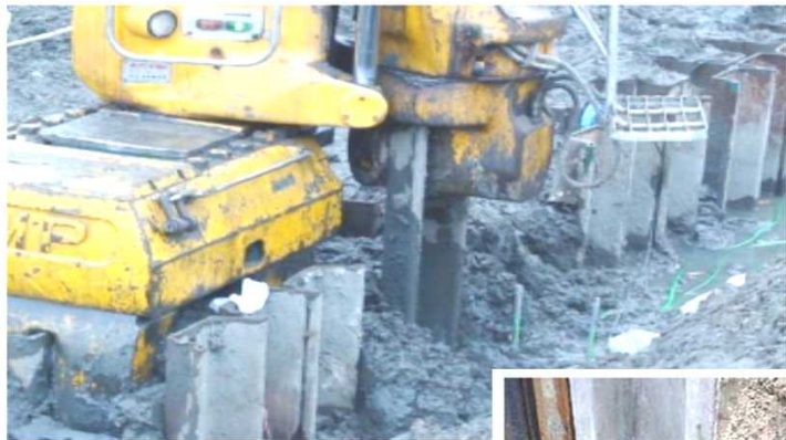
土留め鋼矢板
