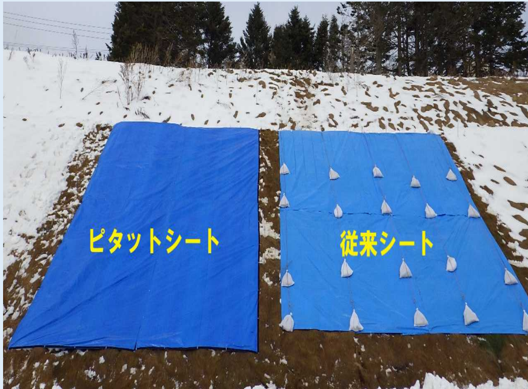
従来式シート布設とピタットシート布設の比較
