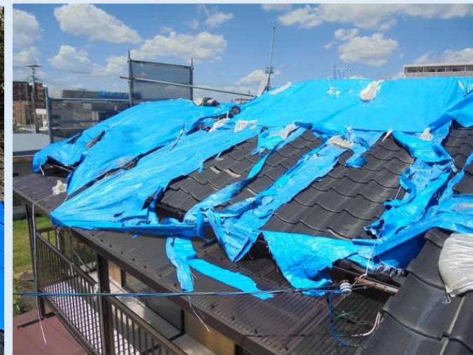
屋根の保護シート
