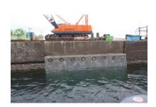
型枠の撤去作業が不要! ⇒工期短縮、コスト縮減
