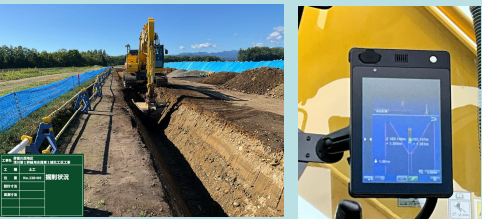
MCバックホウによる掘削状況
