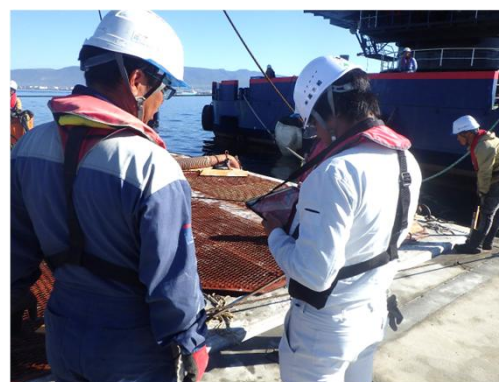
タブレットによるケーソン据付計測確認
