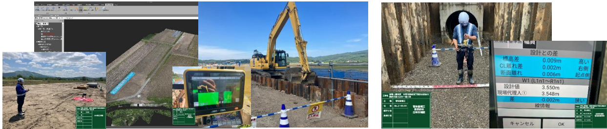
起工測量から電子納品までの3次元施工の実施
