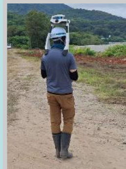
起工測量 (レーザースキャナ)
