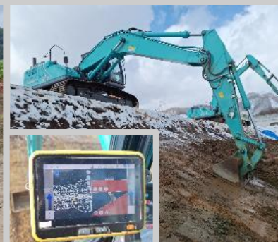
ICT建機による施工
