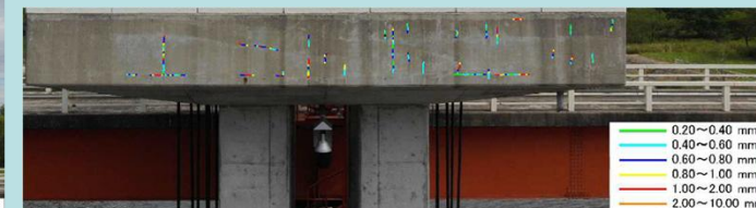
UAVによる写真撮影とひび割れ解析ソフトに状況把握
