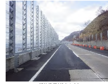
舗装完了(起点から)
