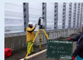
TLS（ライカ社製P40）計測状況
