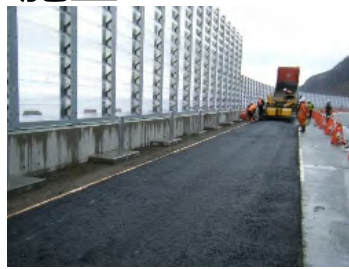
アスファルト安定(上層路盤)施工状況
