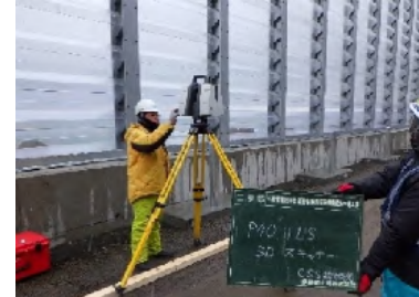
下層路盤出来高測定 (3Dレーザースキャナ)
