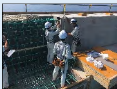
検査状況（現場）
