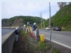
測量状況（3Dレーザースキャナー）
