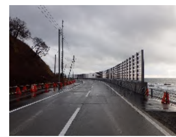
舗装完了(終点から)
