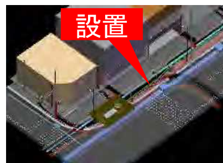
⑦電共管路部設置
