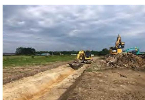
ICT施工機械と専用アタッチメントの併用により丁張設置の省力化と施工速度の向上が図られた。 - 71 -
