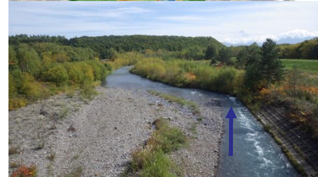
KP35.2 深掘れ箇所
