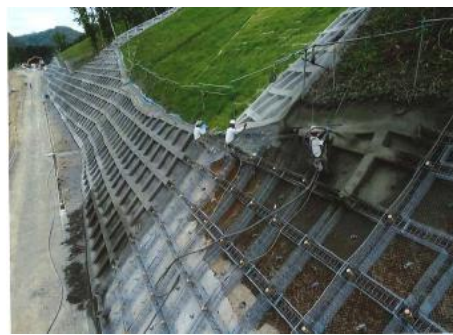
画像事例2（法枠工施工状況（広角）
