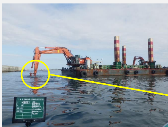
施工(均し)済み範囲が赤着色として表示される
