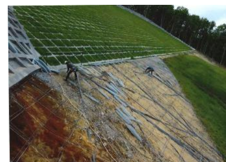
画像事例4（法枠工施工状況）
