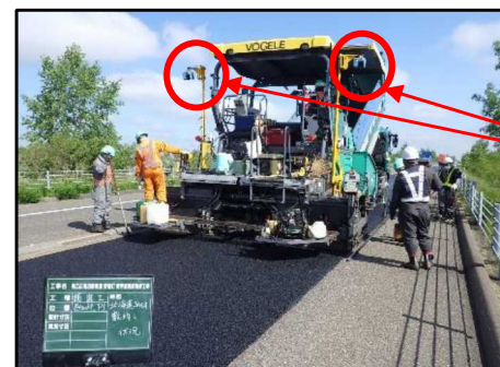
レーザースキャン式スクリード 自動制御装置フィニッシャー
