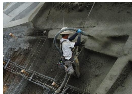
画像事例3（法枠工施工状況（拡大）
