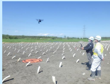
UAVによる起工測量状況
