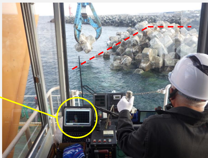
ブロックの据付状況
