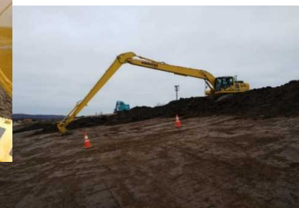
MGスーパーロングバックホウによる法面整形
