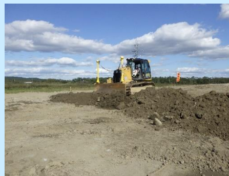
ICT土工施工状況
