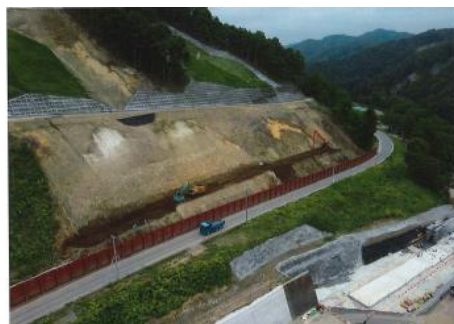
画像事例1（掘削状況）
