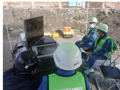
3次元点群データの確認
