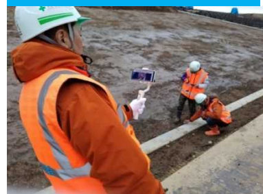
遠隔臨場による出来形測定
