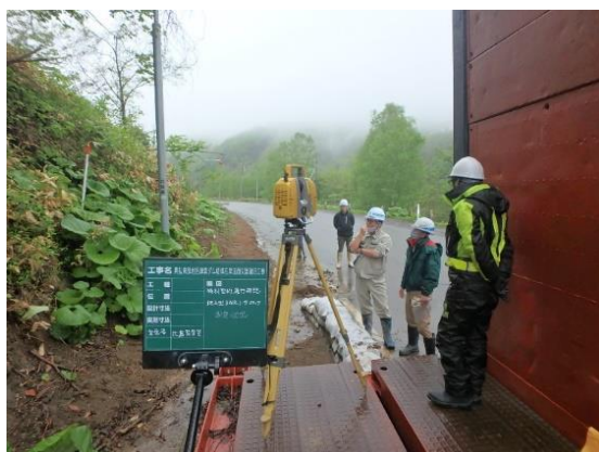
地上型3次元レーザースキャナーによる測量状況
