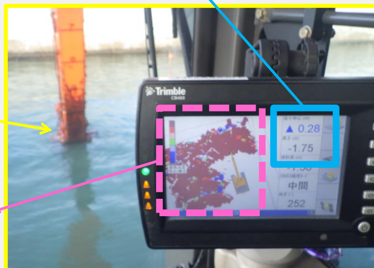
捨石荒均し状況
