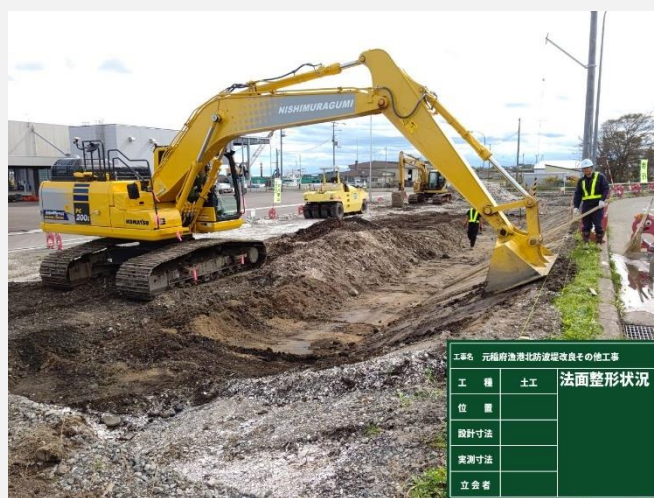
自動整地アシストによる切土法面整形
