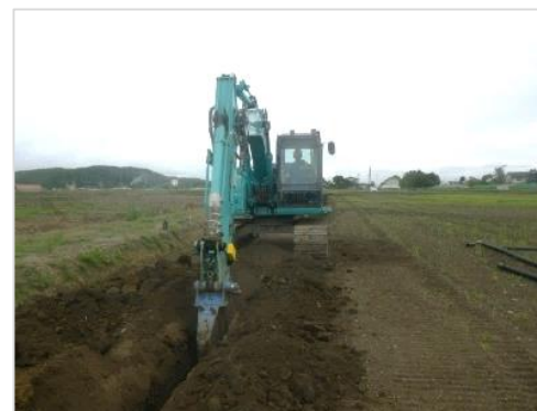
ICT建機による暗渠排水路の掘削状況
