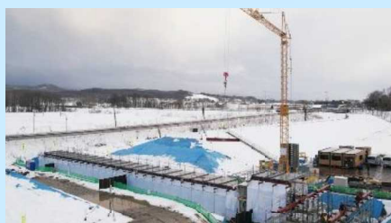
雪寒仮囲設置状況
