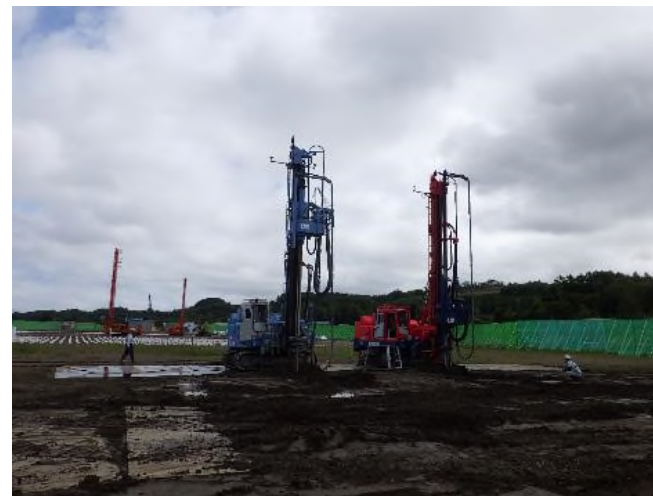
本施工状況 写真2
