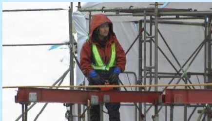
定置式水平ジブクレーン操作状況
