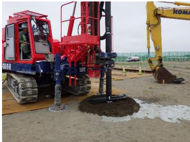
試験施工状況 写真1
