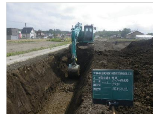
ICT建機による用排水路の掘削状況
