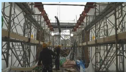
鉄筋搬入状況
