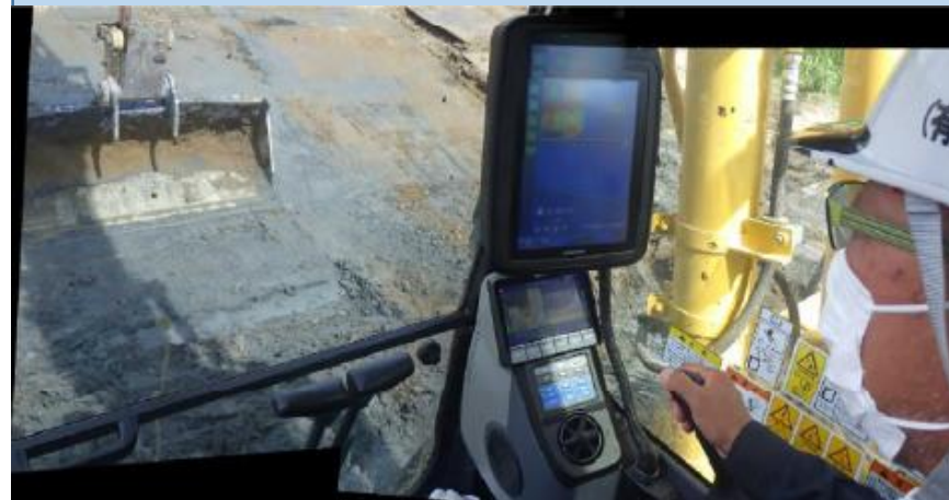
ICT建機自動アシストによる仕上げ状況（法面）
