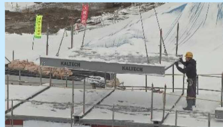
雪寒仮囲屋根撤去状況
