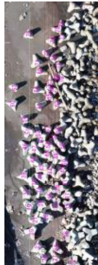
図12 移設数量確認状況（航空写真ベース）
