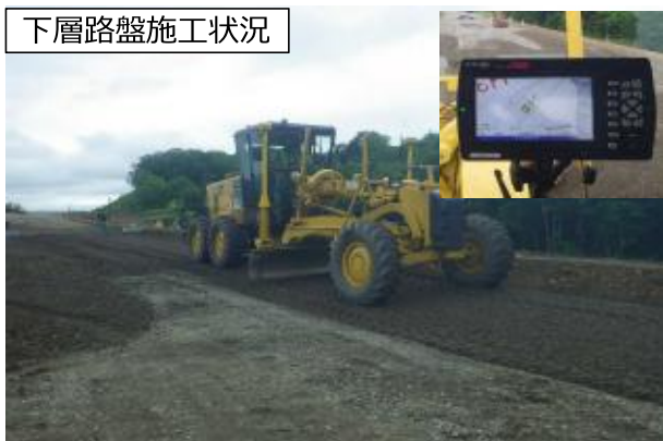
レーザスキャナ出来形測定（下層路盤）
