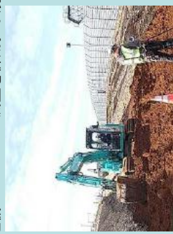
従来建機とワンマン観測による仕上げ前段階作業(左)とICT建機での仕上げ作業(右)
