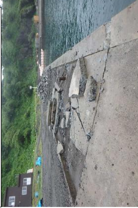
① 既設コンクリート舗装取り壊し(知床岬地区)
