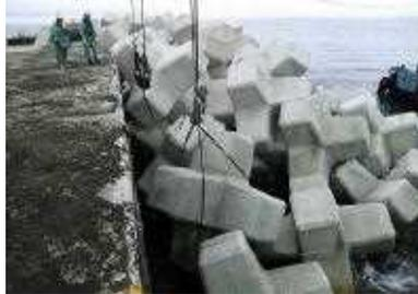
消波ブロックが凸凹しているため完成形状を意識して消波ブロックが上手く収まる位置や向きを試行錯誤しながら据付
