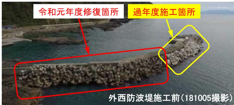
赤線で囲ってある範囲の消波ブロック沈下箇所に製作した消波ブロックを据付し修復する。
