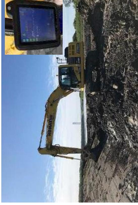
ICT施工：河道掘削（MCバックホウによる施工）
