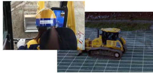
ICT建機による施工
