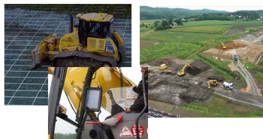
ICT建機での施工
