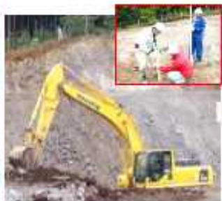
丁張りを目印に施工
