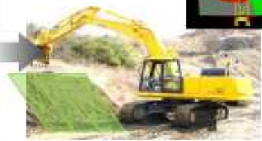
3次元設計データに沿って施工
