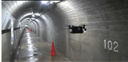
UAVを活用したダム監査廊巡視点検
