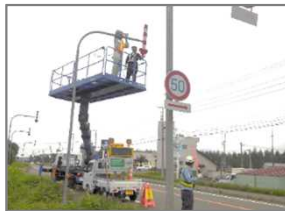
・高所作業車による点検
