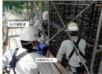
①臨場(受注者)の状況
