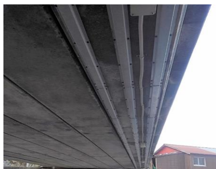
PCプレテン床版橋 桁1本の部分防食
