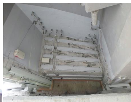
PCポステンT桁橋 桁端部の部分防食
