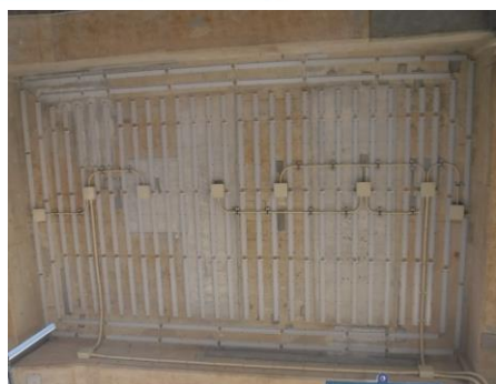
RCラーメン橋 床版全体を防食
