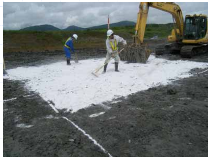
不溶化剤敷設
