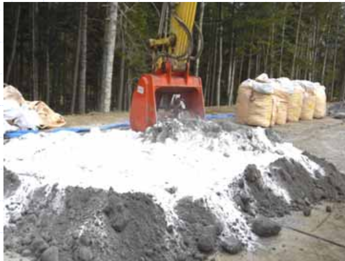
バックホウ混合 30 \text{ m}^3 / \text{h}
