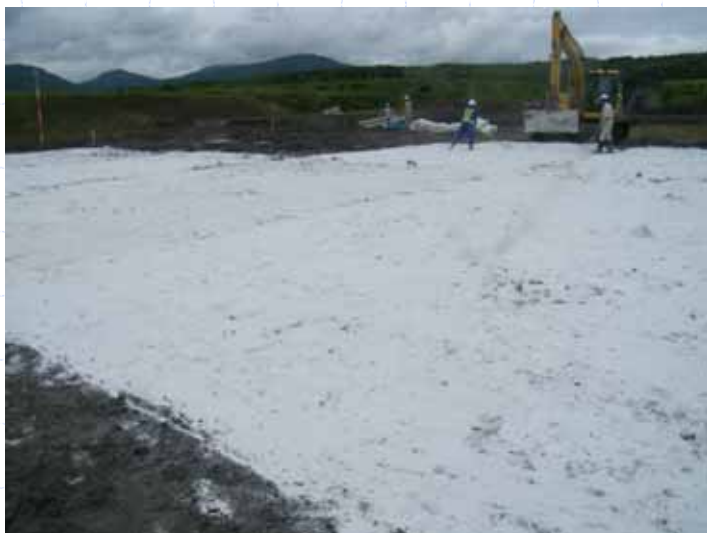
不溶化剤敷設完了
