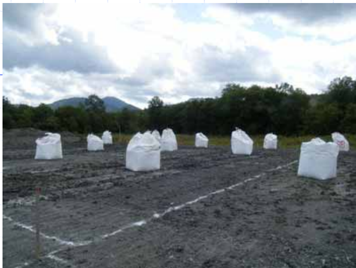
不溶化剤設置
