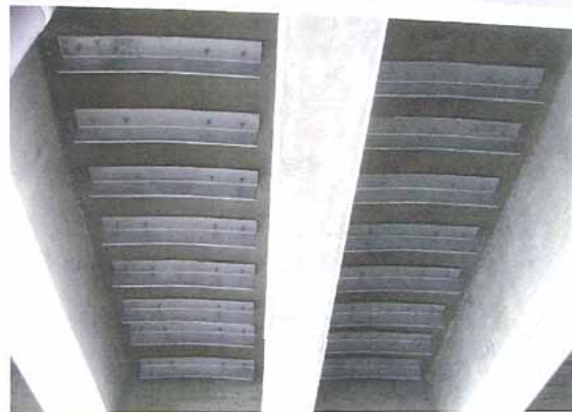
新開橋(PC橋 間詰め補強)
