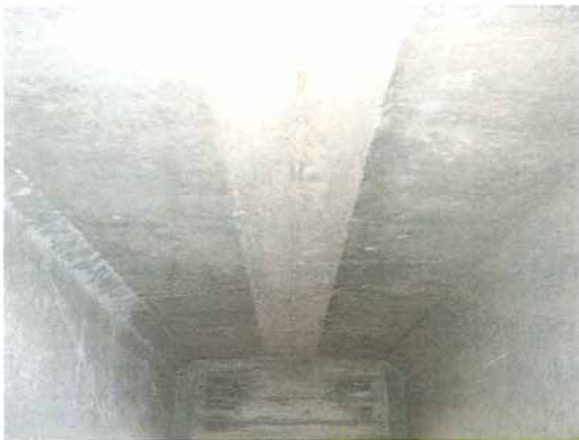
新開橋(PC橋 間詰め補強)
