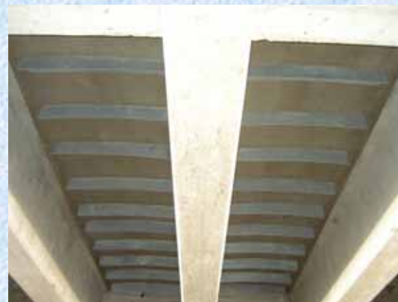
P C 橋 (間詰部補強)
