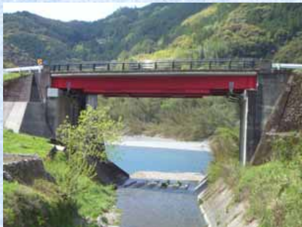
高知県:石見橋
