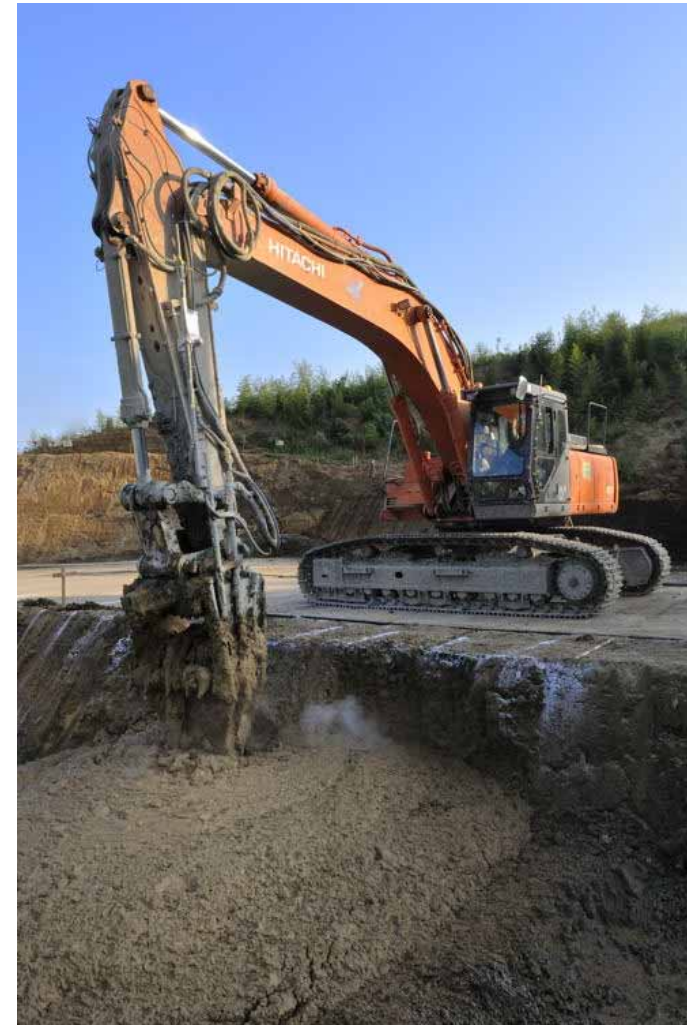
混合攪拌状況
