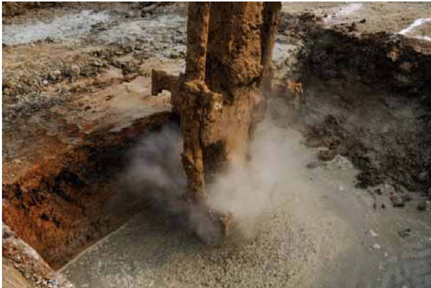
高温なセメントスラリー吐出状況
