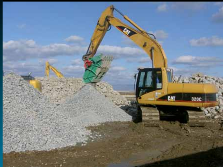
函館開発建設部発注 奥尻港物揚場(北)その他工事
