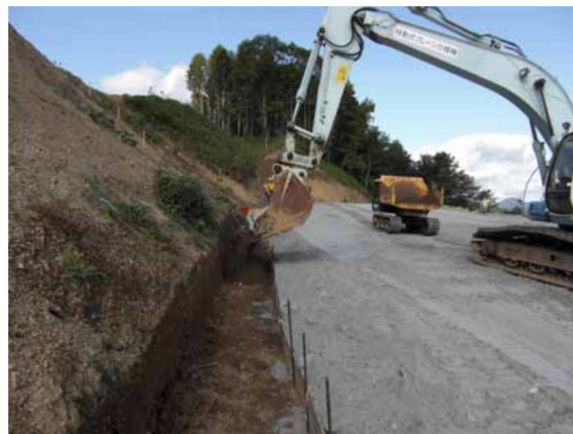
段切り部分の吸着層 吸着材投入状況
