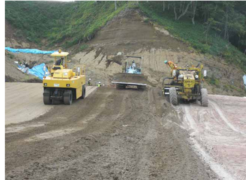
薬剤混合攪拌、ブル敷き均し タイヤローラによる一次締固め
