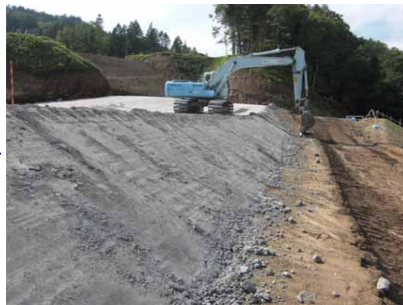
トンネルズリ受入れ 法面整形
