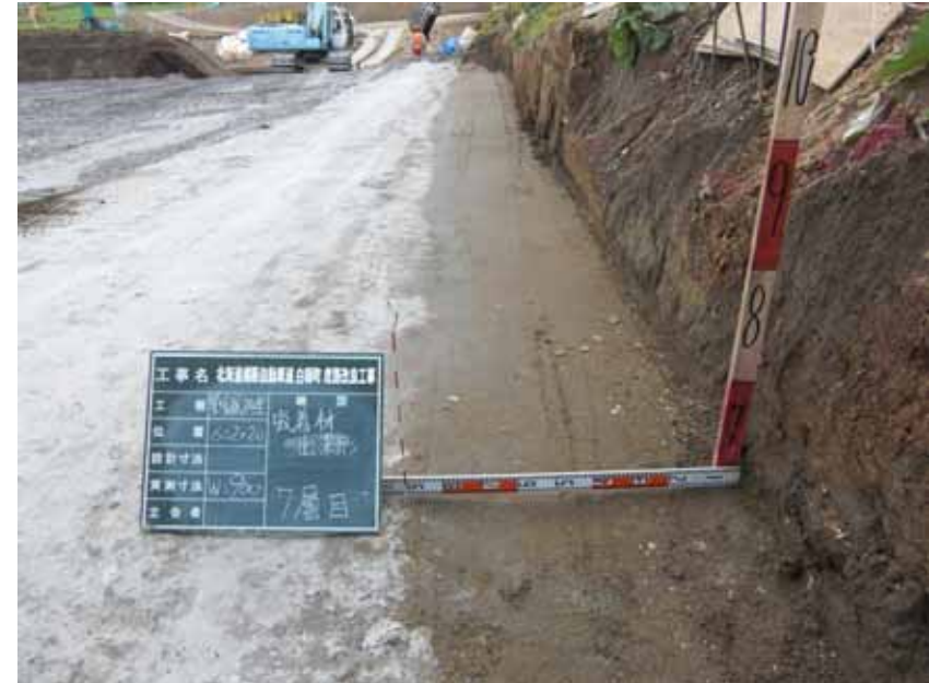
切り部分の吸着層 吸着混合材出来高 7層目 W=0.90m , H=0.30m
