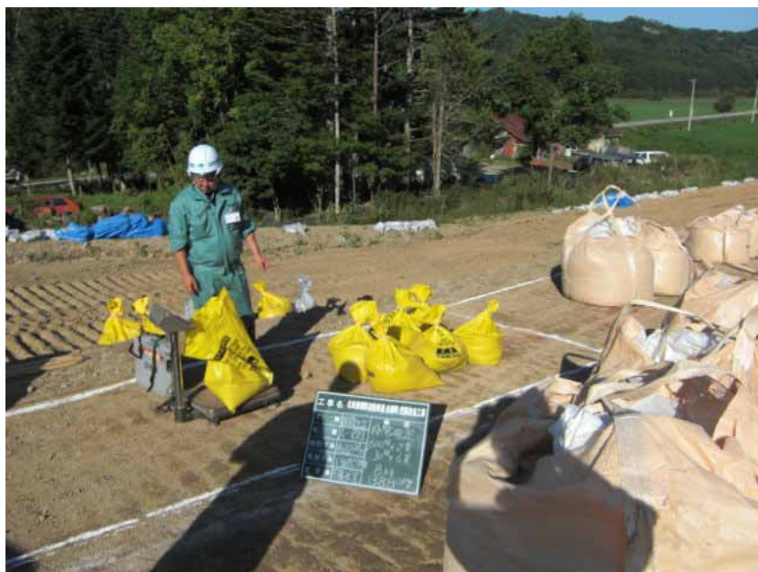
端部の薬剤計量 監督員の検査
