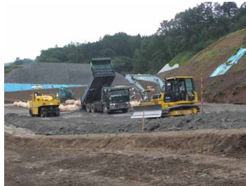
トンネルズリ受入れ
