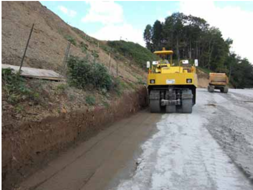
段切り部分の吸着層 吸着材締固め状況
