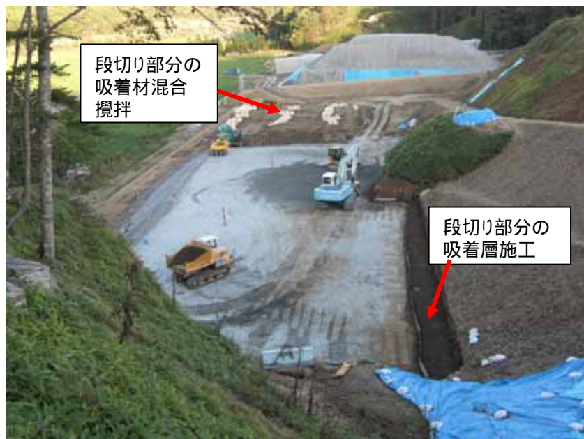
トンネルズリ受入れ及び 段切り部分吸着材混合攪拌
