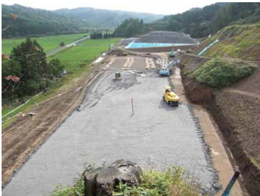
トンネルズリ受入れ
