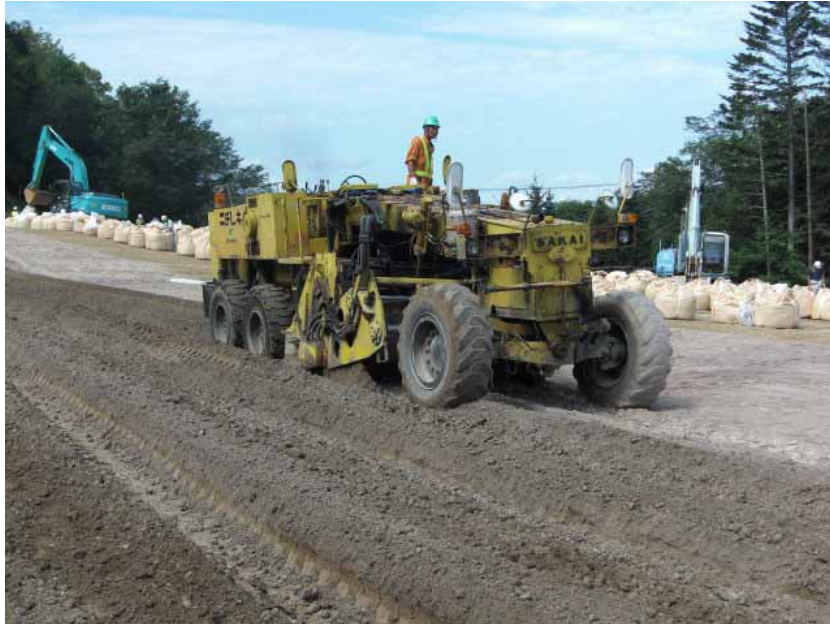
薬剤の混合攪拌 (ロードスタビライザー深さ30cm)
