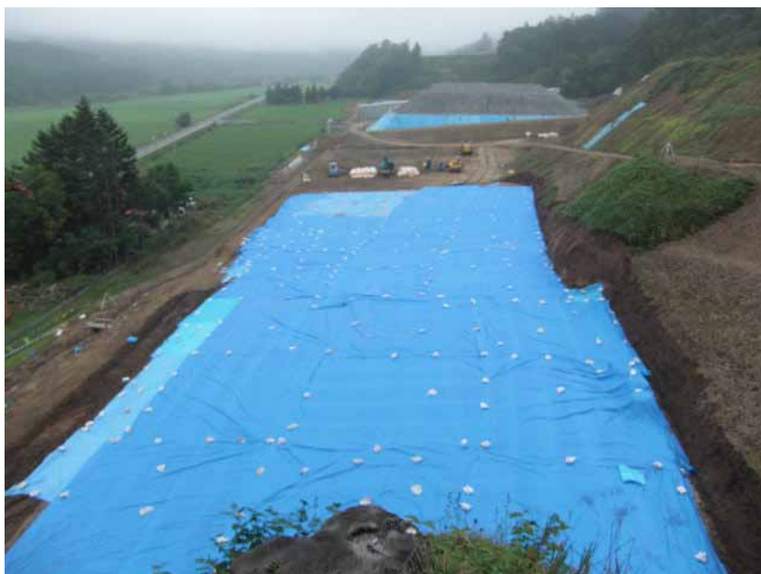
薬剤混合攪拌完了及び シート養生
