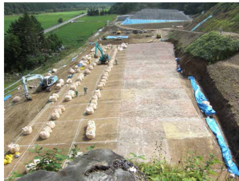
薬剤散布 半断面完了
