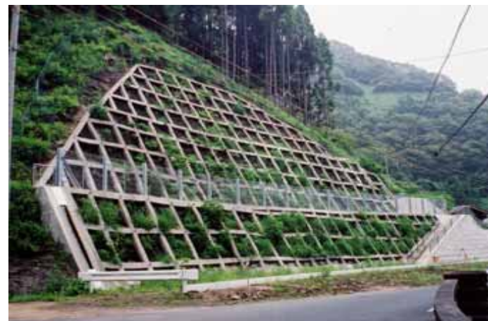
平成15年8月（施工後5ヶ月）
