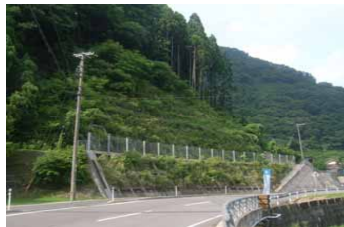
平成20年7月（施工後64ヵ月後）
