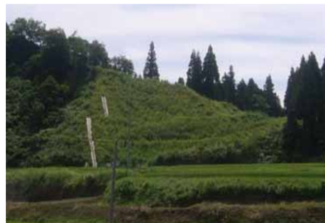
平成20年8月（施工後22ヶ月）
