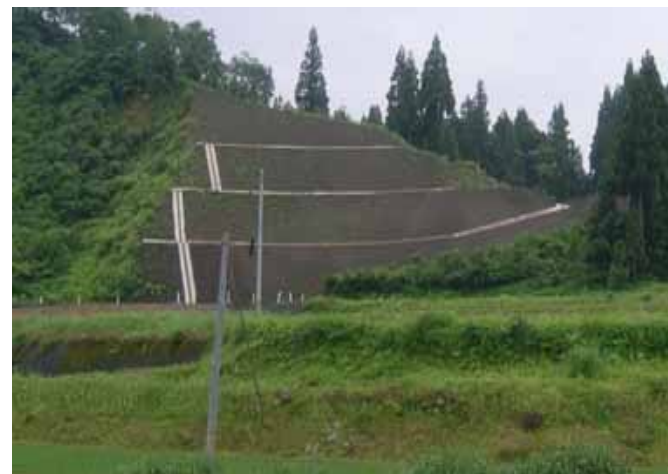
平成19年7月（施工後8ヶ月）
