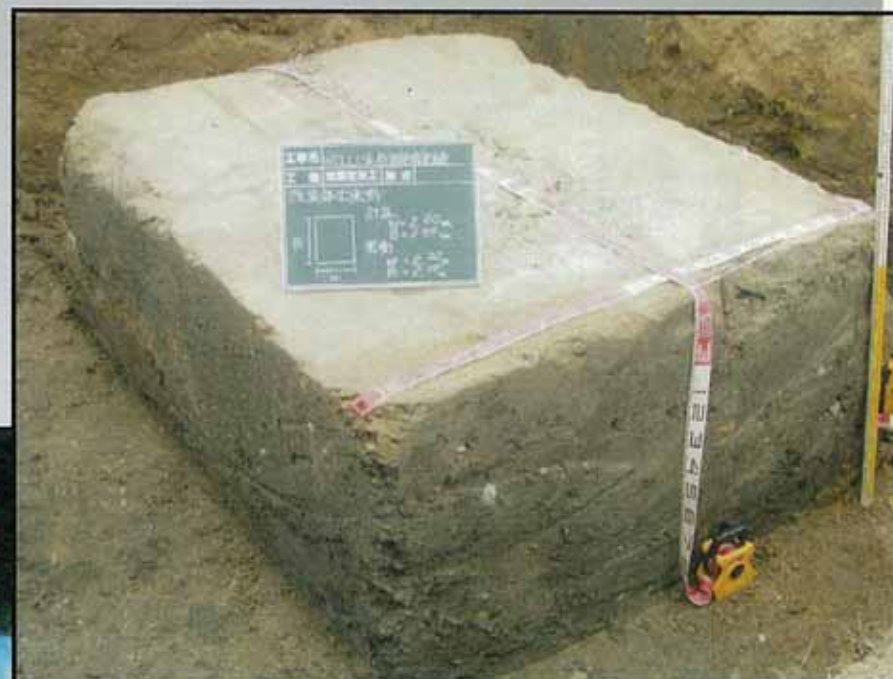
改良体出来形確認
