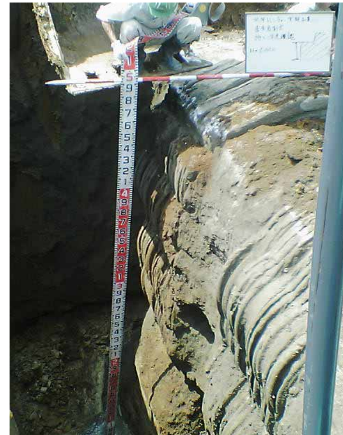
水平トレンチャー先端部 出来形状況
