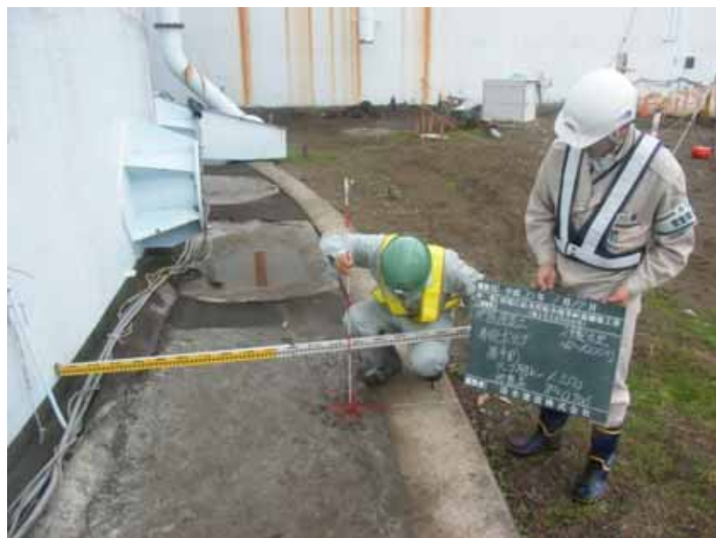
ボーリング採取位置
