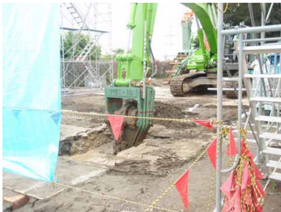
鉛直トレンチャー施工状況
