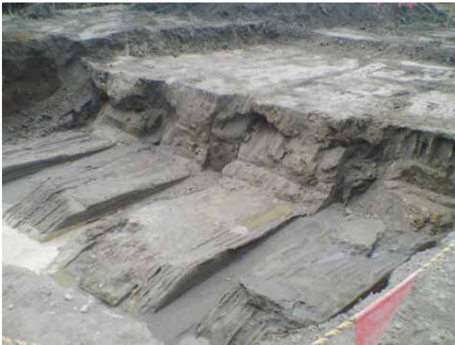
各パターンの表層部 出来形状況
