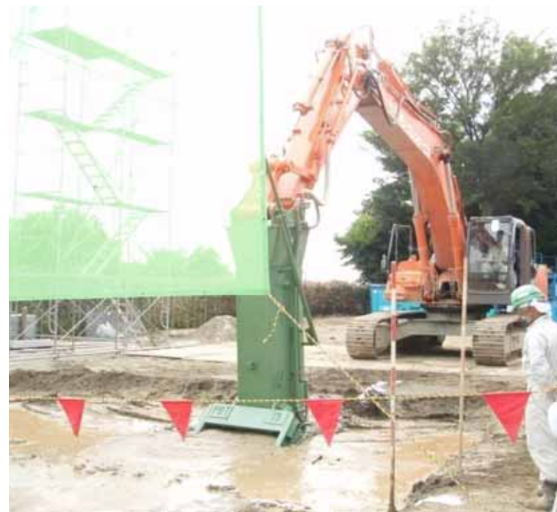
水平トレンチャー施工状況
