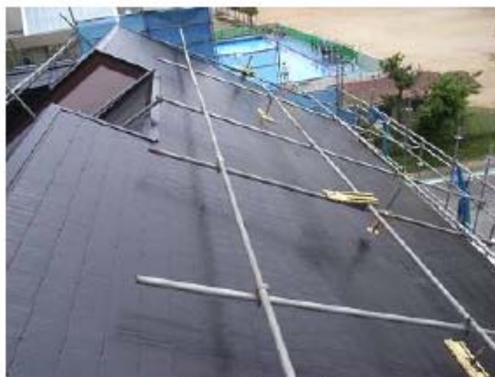
屋根 汚れ防止
