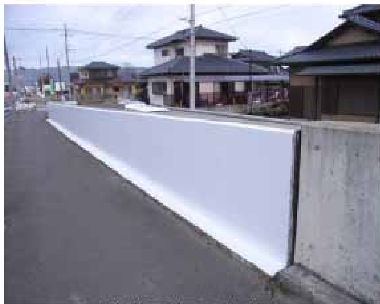
道路側壁 汚れ防止
