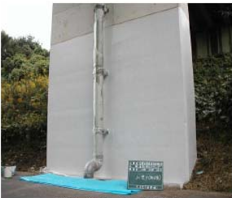
橋脚 汚れ、落書き防止
