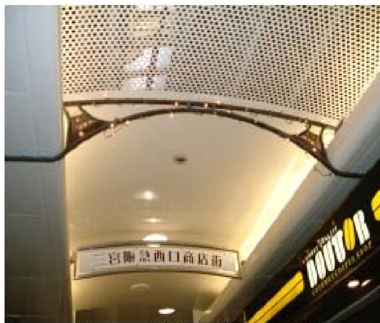
アーケード内装 美装仕上げ
