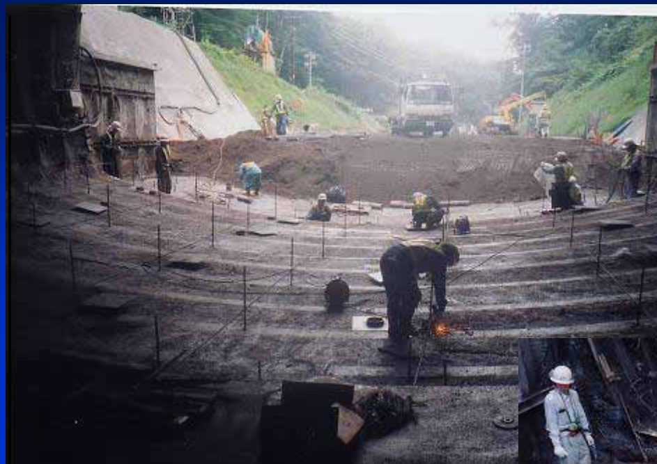
〔頭部処理状況〕
