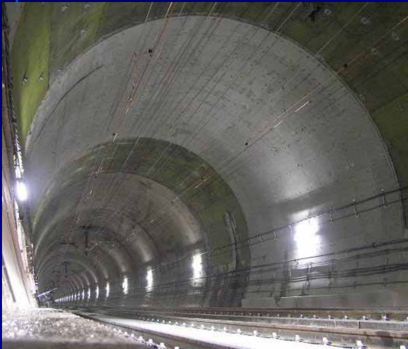
トンネル覆工コンクリートの補強
