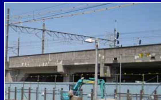
高架橋高欄(全景)
