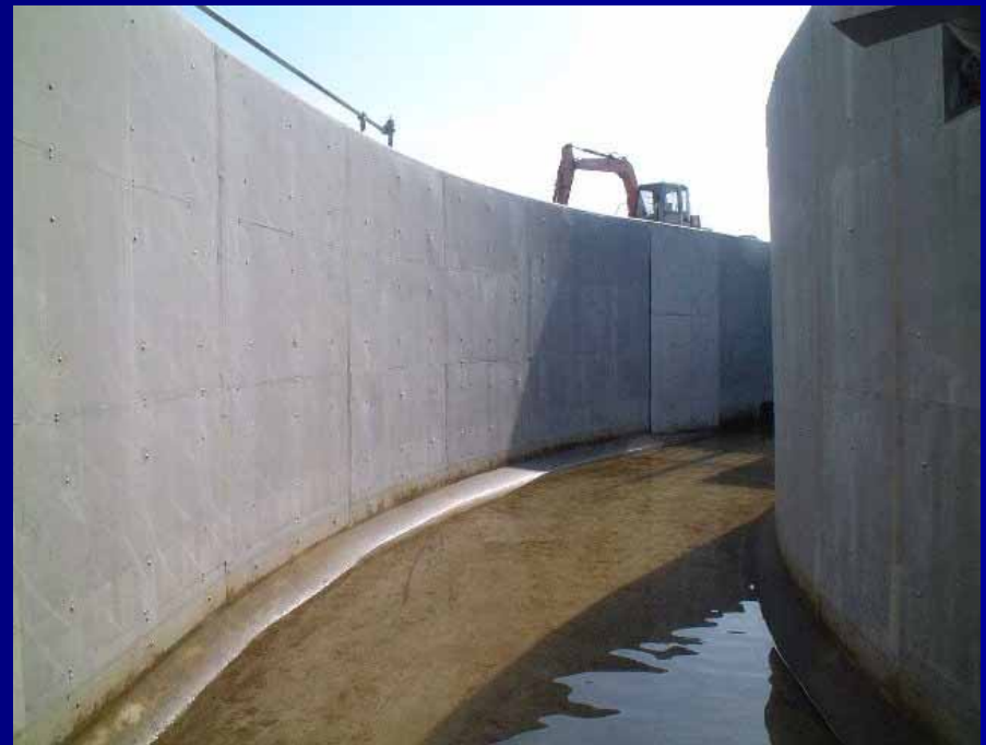
新設構造物の埋設型枠
