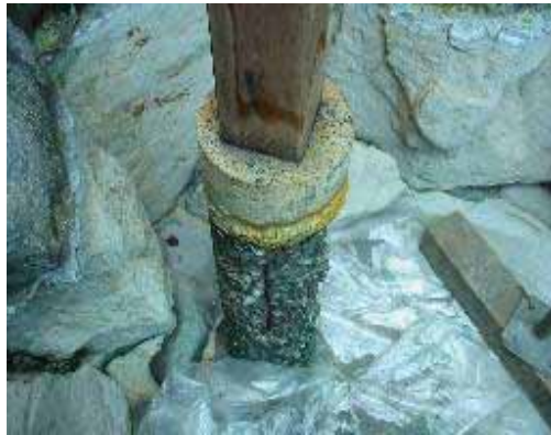
施工前の状況
