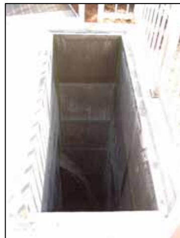
施工後 （上面部）
