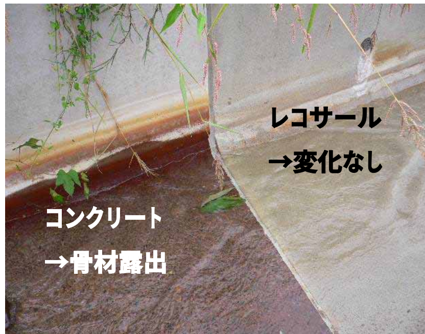
事前の試験施工
