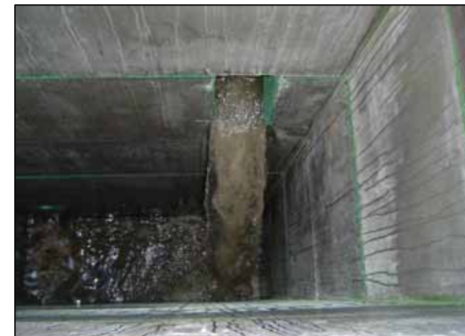
供用開始（2003.11） から6年後も腐食なし
