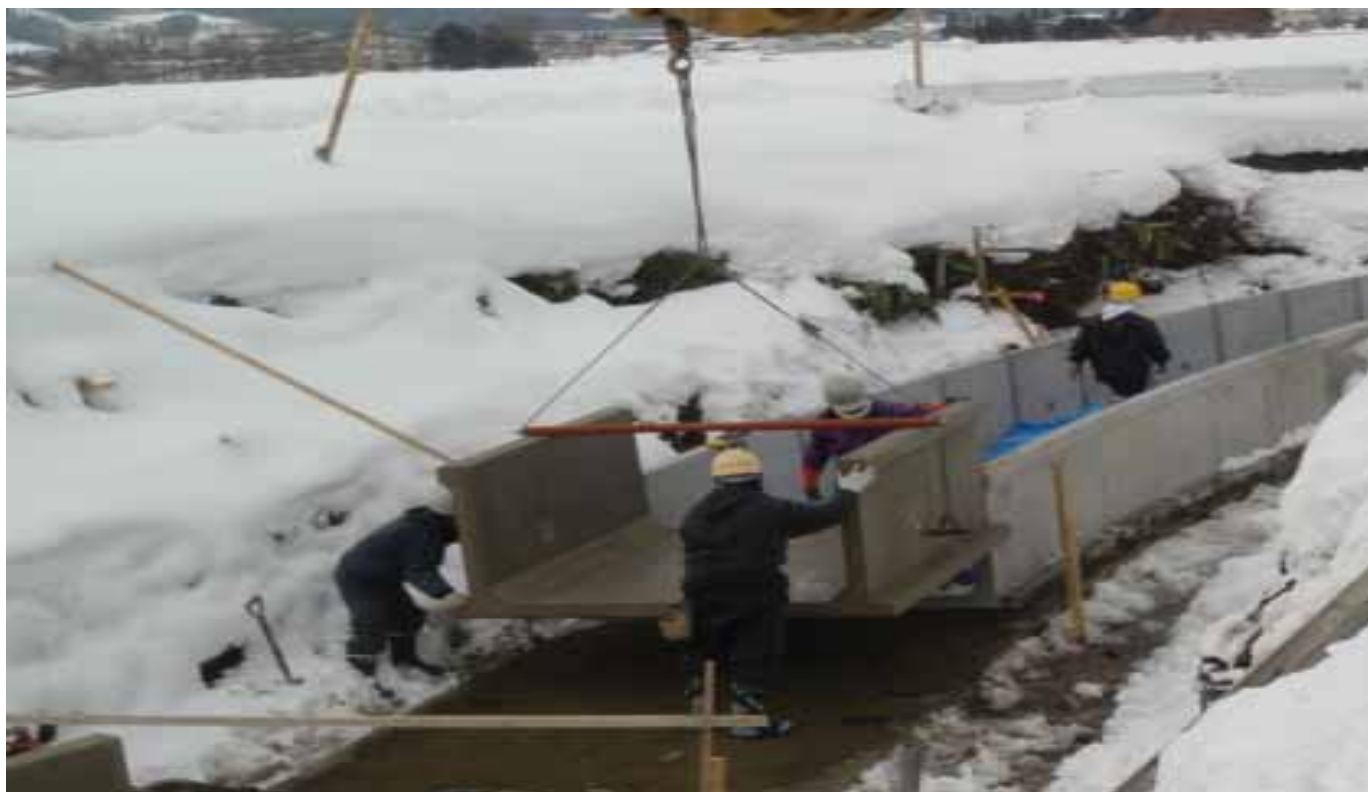
農業用大型水路（U字溝）試験施工 青森市大別内 （2005.12）
