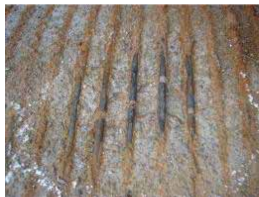
カバーコートの薄肉化と PC鋼線の破断
