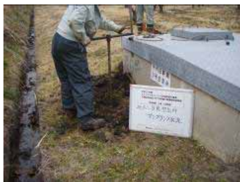
オーガーボーリングによる掘削
