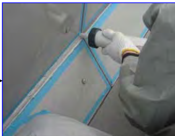
④目地材シーリング
