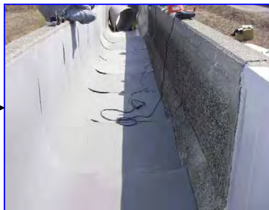
②緩衝材設置
