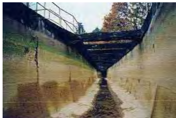
補修前の水路橋内面
