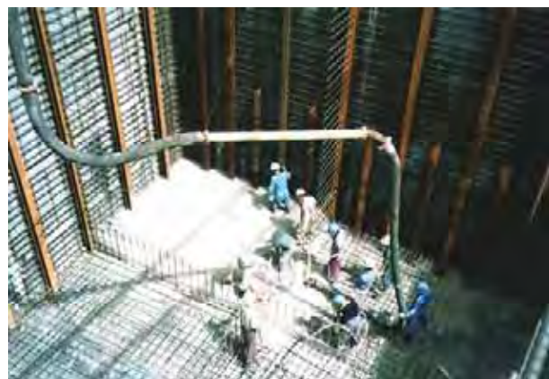
底版コンクリート打込み
