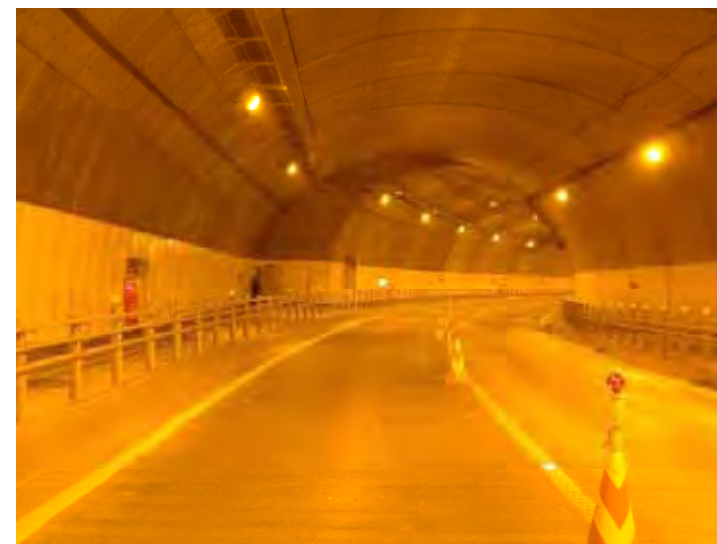
覆工完了後の打増し部および中壁部の状況
