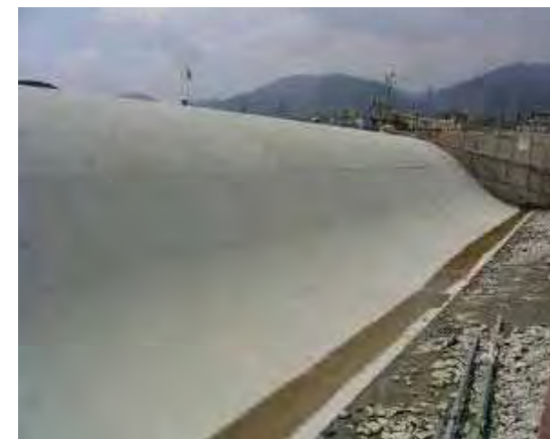
完成した固定堰
