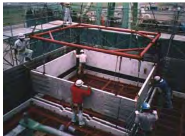
中壁部のPCa部材の建込み
