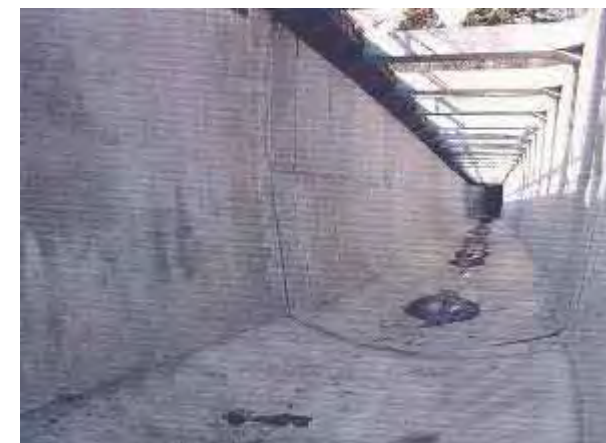
補修完了状況
