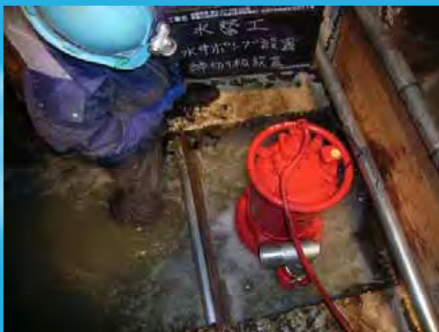
②上流人孔水替状況
