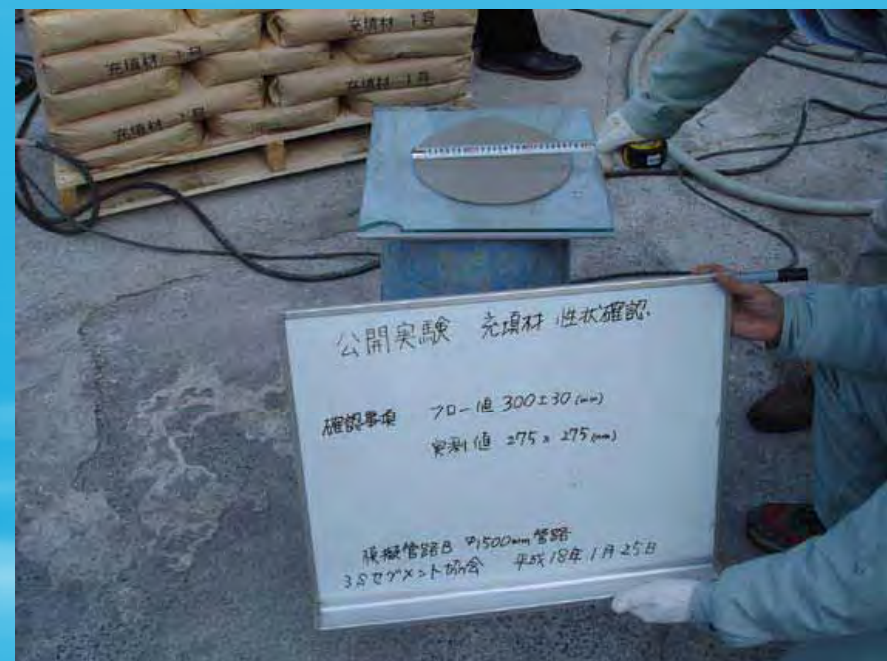
充填材フロー値測定状況
