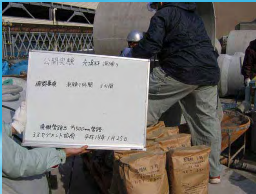
充填材練り混ぜ状況
