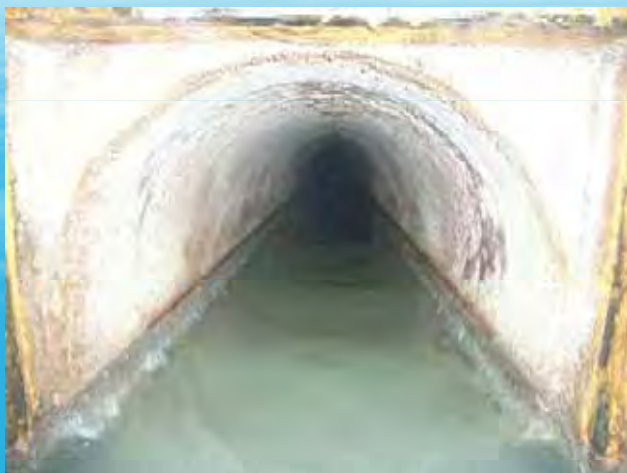
①施工前供用状況
