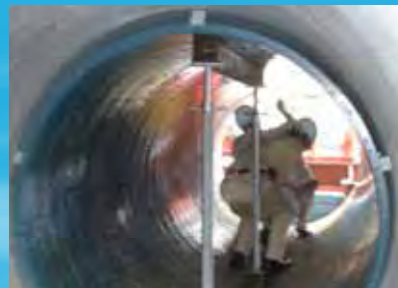
サポート設置状況
