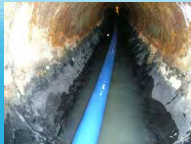
③管内水替状況
