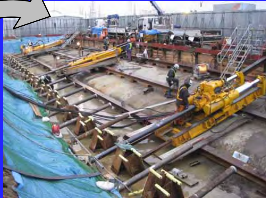
削孔作業状況(仮囲い工事エリア内)
