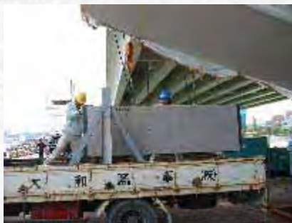
①曲げ補強鉄筋建込・固定 水中部プレキャストパネルの設置
