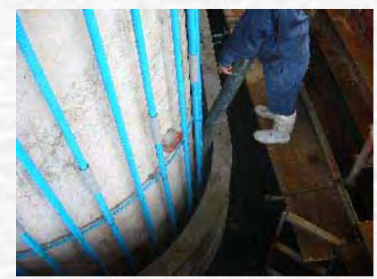
③補強鉄筋の接続 気中部プレキャストパネルの設置 低収縮コンクリート充填
