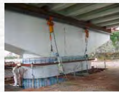
③補強鉄筋の接続 気中部プレキャストパネルの設置 低収縮コンクリート充填
