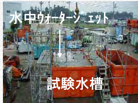
水中表面処理試験施工
