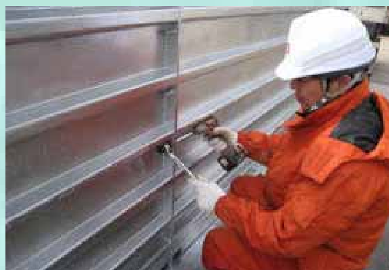
④ 水路連結作業
