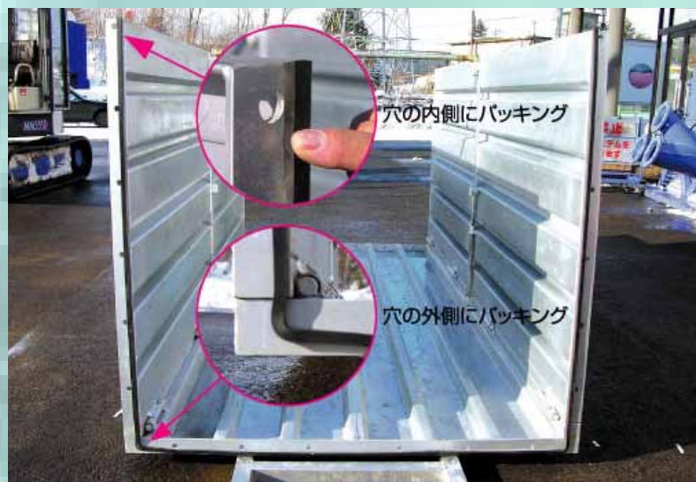
③ 水路連結部止水施工
