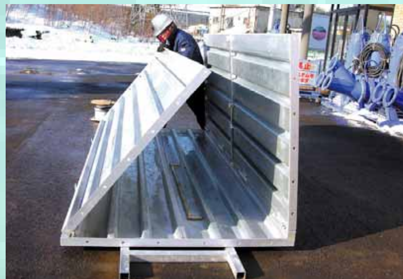
② 水路組立作業
