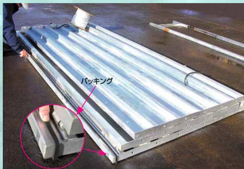
① 止水パッキン施工
