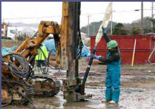
2. 注入外管建て込み
