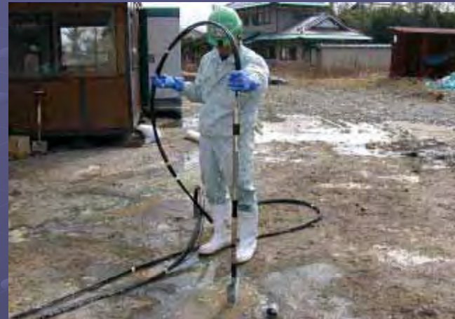
3. 注入内管建て込み
