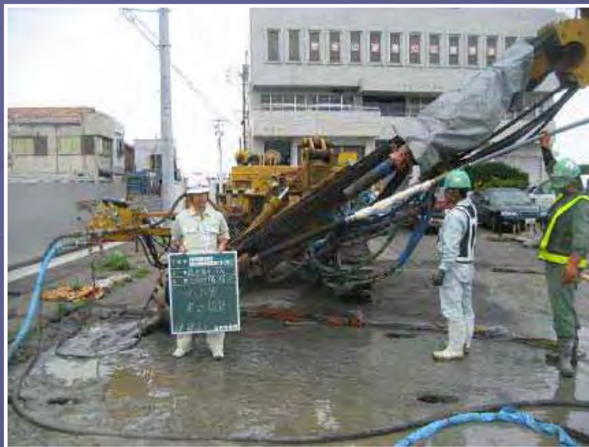
注入外管建込状況
