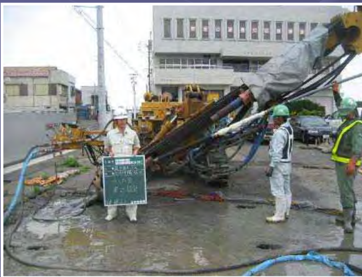
注入外管建込状況
