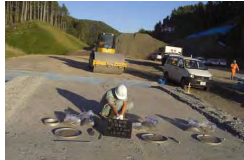
現場密度試験
