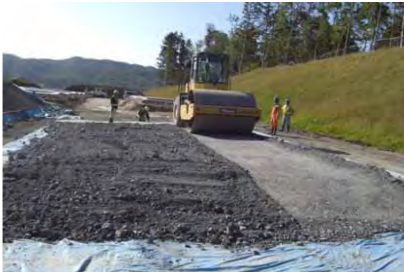
転圧状況（10t級コンバインドローラー）
