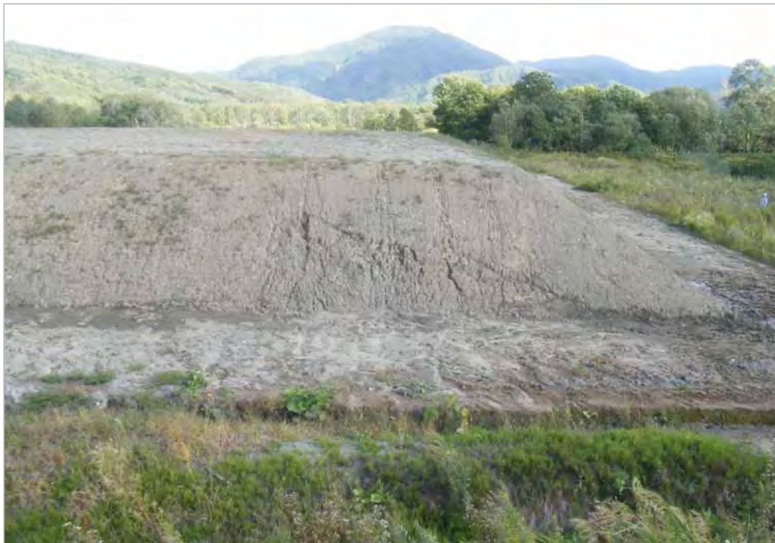
⑤盛土完成状況(覆土後)
