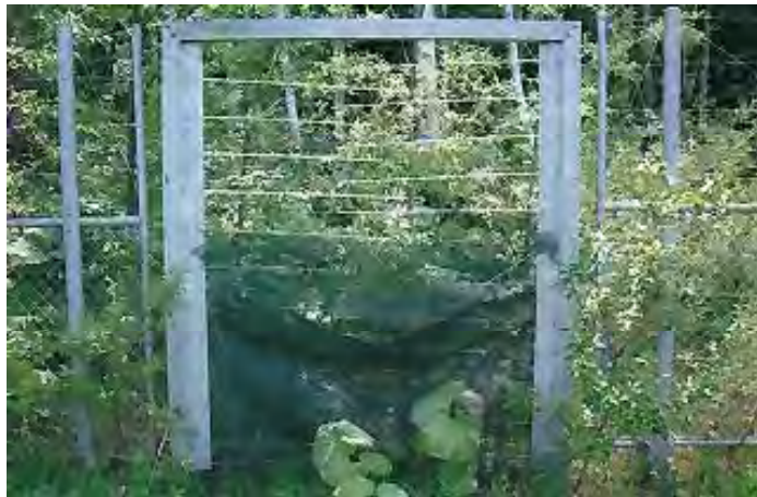
小動物の侵入口となるため閉鎖されたゲート
