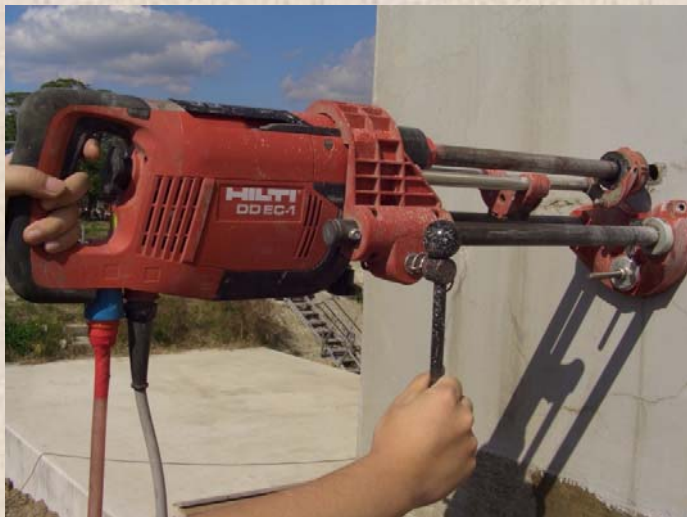
削孔 (小型コアドリルで削孔)
