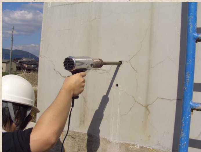
乾燥 (パイプを取り付けたドライヤで乾燥)
