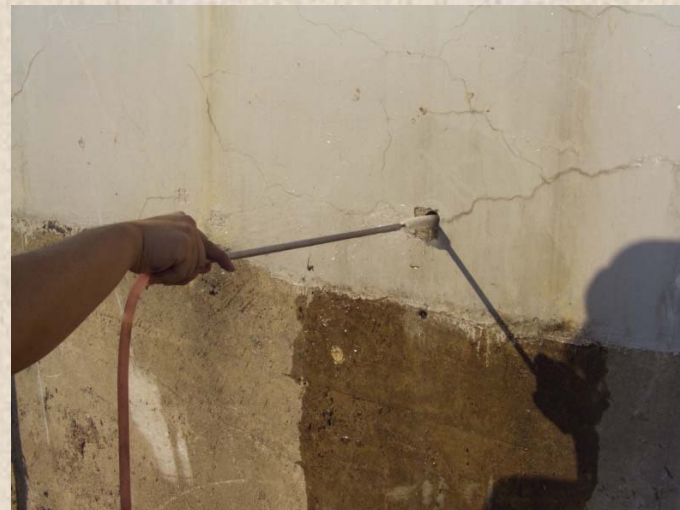
洗浄 (水を流しながらブラシで孔内を洗浄)
