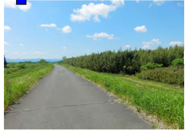
震災後、ポンテラン改良土を用いた築堤箇所 平成23年4月撮影
