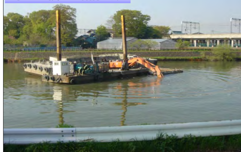
河川堆積土 掘削状況
