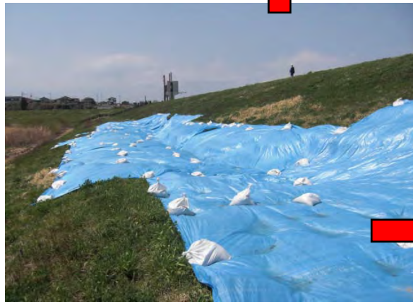
震災後、現地発生土を用いた築堤箇所 (大規模せん断破壊が発生) 平成23年4月撮影
