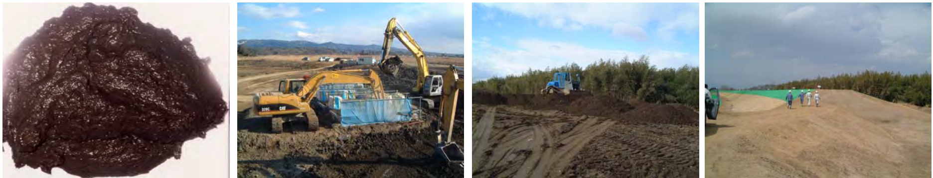
遊水地内の軟弱土を現場内でボンテラン改良し、築堤材料として利用 (撮影日:平成14年12月)
