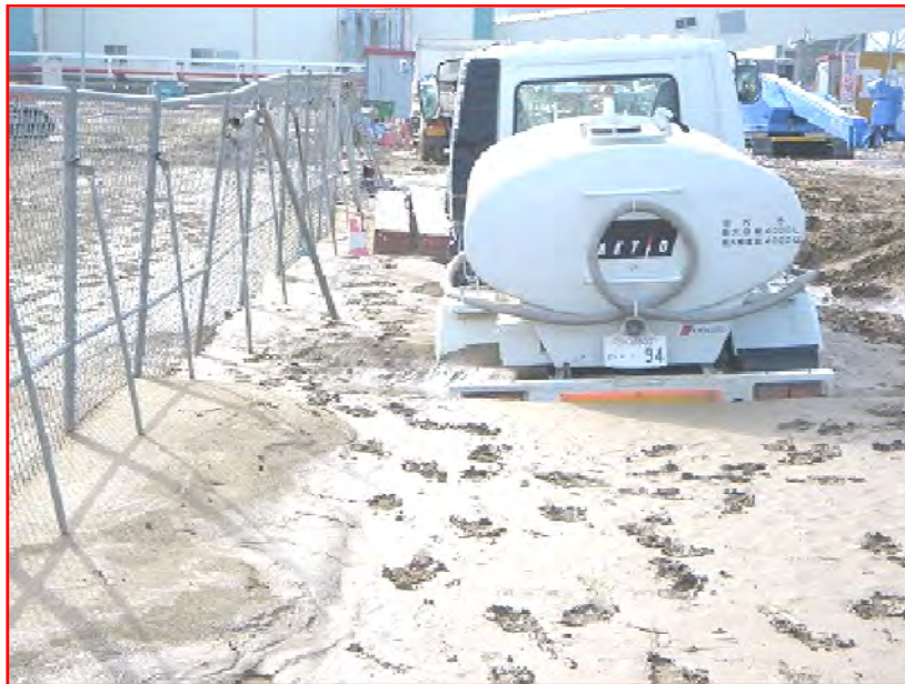
液状化による沈下
