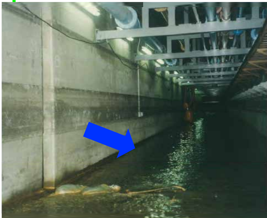
1995年兵庫県南部地震時の管廊施設への土砂等の流入状況
