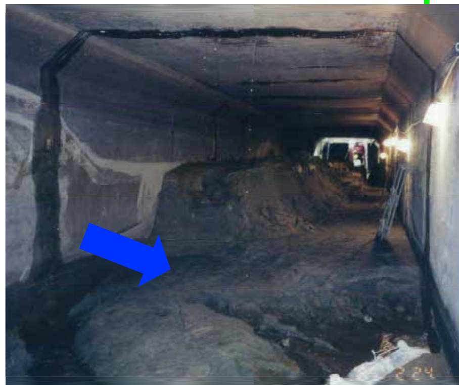
1995年兵庫県南部地震時の管廊施設への土砂等の流入状況
