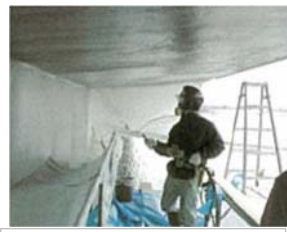
UUライニングの吹き付け
