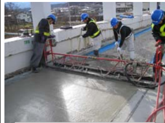
タフスラブ・ラピッド工法施工
