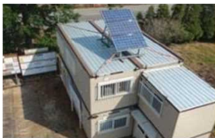
工事事務所での太陽光発電
