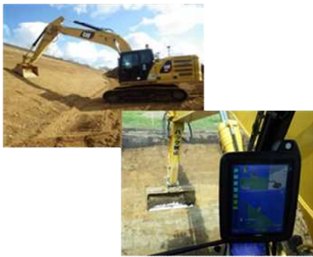
道路新設工事におけるICT施工
