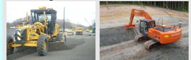
(車道路盤施工状況)
