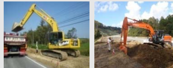
(ハイブリッド型バックホウ施工状況)
