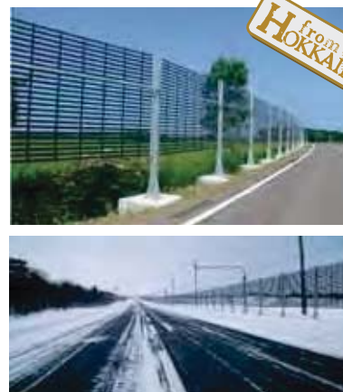
■ベルト式ネットフェンス 設置状況
