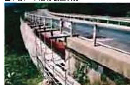
■H鋼アーム足場 設置状況
