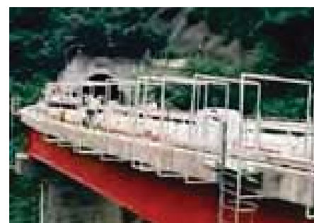
■単管フープ足場 設置状況
