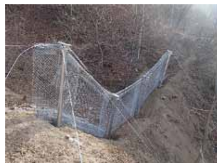
■フェンス設置状況
