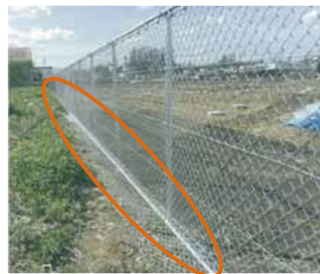
■網設置状況(下部閉塞)
