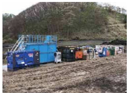
■システム設置状況
