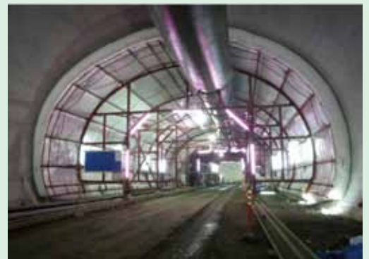
■現場設置状況
